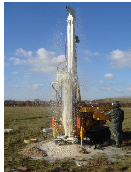
Forage au rotary
