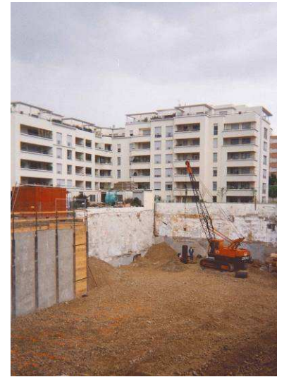
Fouille de chantier
